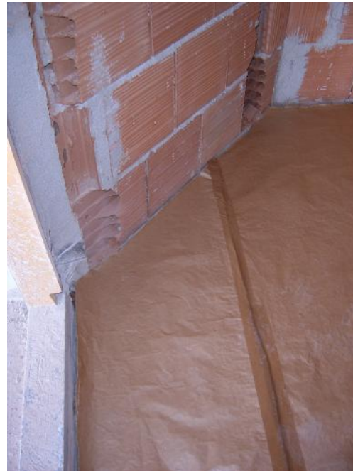
(Isolamento costituito da pannelli di sughero + strato separatore anticalpestio)
