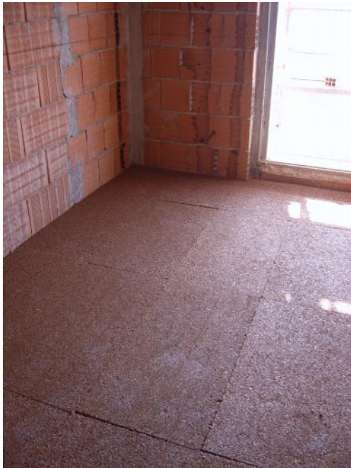
(Isolamento costituito da pannelli di sughero + strato separatore anticalpestio)
